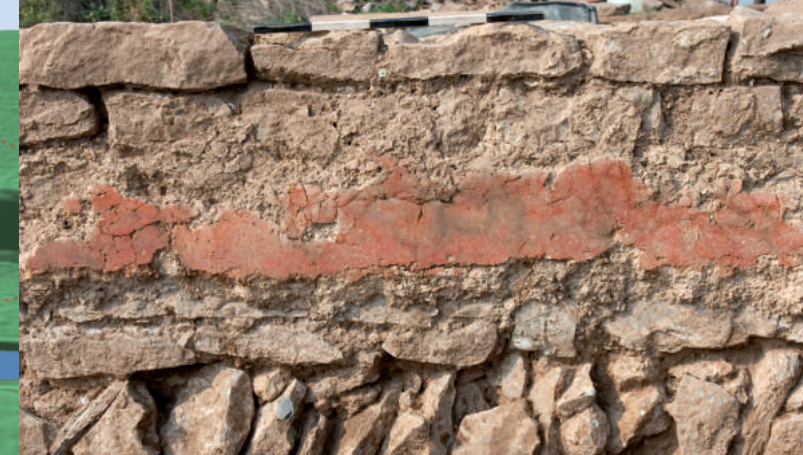
Die Sockelmauer für die Säulen des Umgangs wies außen einen flächig Rot bemalten Wandverputz auf. Dieser ist wohl als Schutzanstrich für die Sockelzone gedacht.
