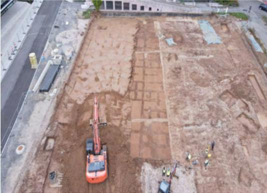
Übersicht über die Grabungsfläche: Im Westen wird der bereits freigegebene Bereich für den Neubau ausgehoben, im mittleren Streifen zeichnen sich die Suchgräben der Grabung 1966 ab, rechts im Bild die noch zu untersuchenden Bereiche.
